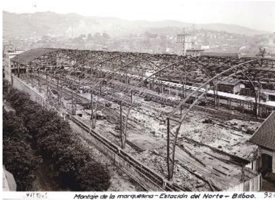
Montaje de la marquesina - Estación del Norte - Bilbao. 1920
