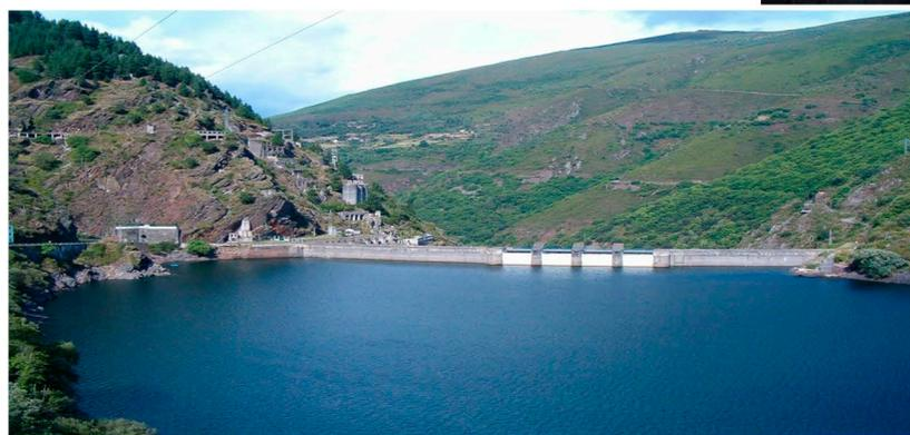
La central hidroeléctrica de Salime se encuentra situada bajo el aliviadero de la presa del embalse del mismo nombre. Cuenta con cuatro grupos generadores de 32MW cada uno, que entregan la energía a una tensión de 11.000 voltios, y que fueron puestos en explotación comercial entre 1953 y 1956. En total suman 128 MW y una energía producida de 350 GWh de media al año.
